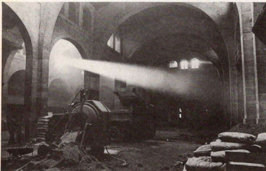
l'entrepôt Lainé pendant les travaux de réfection en 1978
